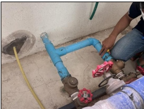
รูปที่ 2-61 ช่างซ่อมบำรุงตรวจสอบรอยรั่วของเส้นท่อประปาหรือปั้มน้ำ
