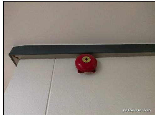
รูปที่ 2-32 กริ่งสัญญาณเตือนอัคคีภัย
