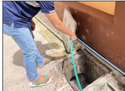
รูปที่ 2-11 เจ้าหน้าที่ล้างทำความสะอาดท่อระบายน้ำ โดยรอบอาคาร 2 ครั้ง/ปี
