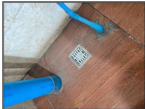
รูปที่ 2-23 ท่อรวบรวมน้ำจากการล้างห้องพักมูลฝอยรวม
