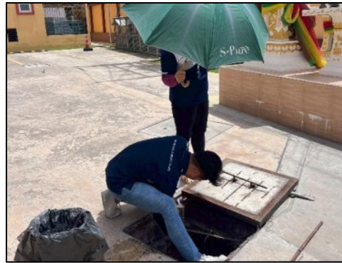
รูปที่ 2-58 เจ้าหน้าที่ตักไขมันจากถังดักไขมันอาคาร A และ B
