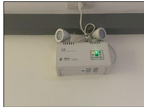
รูปที่ 2-29 ติดตั้ง Emergency Light
