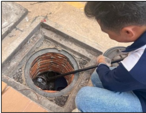
รูปที่ 2-58 เจ้าหน้าที่ตักไขมันจากถังดักไขมันอาคาร A และ B
