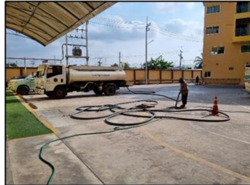
รูปที่ 2-17 ผู้รับเหมามาสูดกากตะกอนออกจากบ่อเมื่อบ่อเกรอะเต็ม
